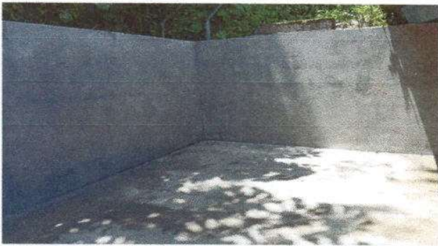
Foto 7: El muro se cuenta en proceso de remozamiento
