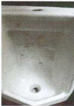
Foto 9: Se inicia la sustitución de llave en mingitorio
