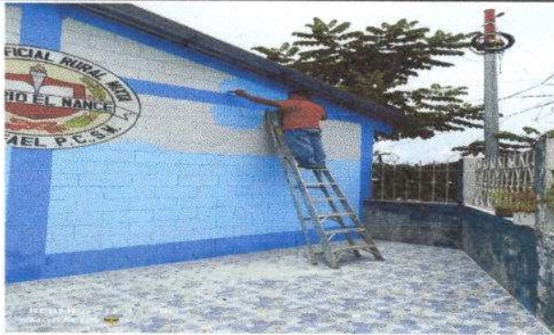
Foto 3: Pintando en muros exteriores
