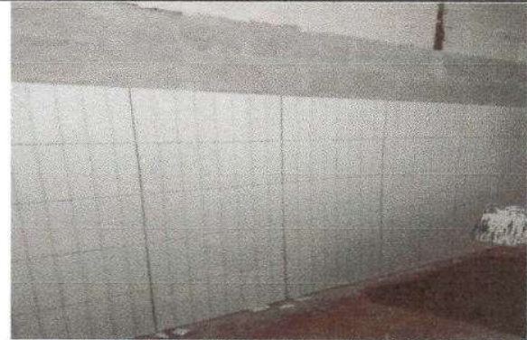
Foto 10: Se inicia de trabajos de azulejo en la cocina
