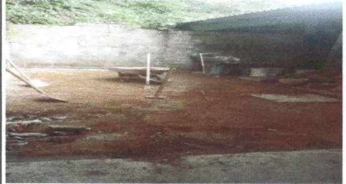
Foto 8: La planchas de concreto del patio se están remozando
